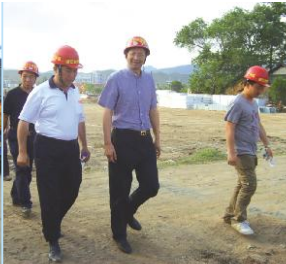
台州市建设规划局局长程进(中)在总经理王明生(左)的陪同下视察我援建施工工地,右为张灵刚。
